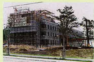
建設中の現役場庁舎
