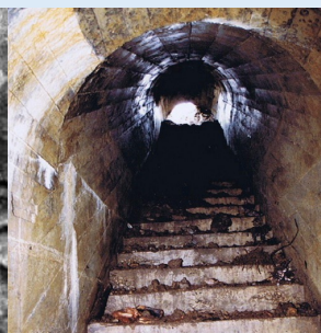
中標津空港敷地内に遺る戦闘指揮所地下部分
