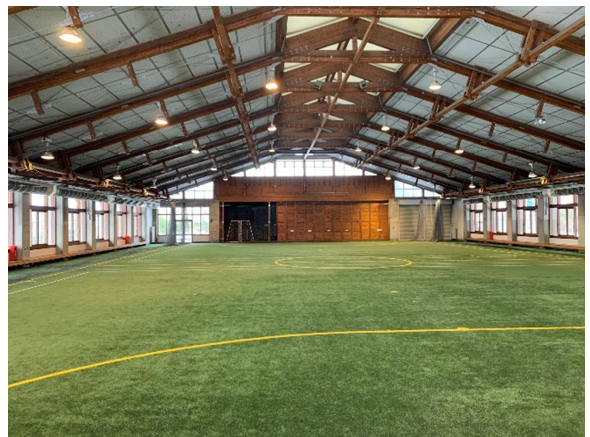
稲荷下屋内運動場
