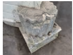
写真 9-30 旧庁舎の礎石の状況
