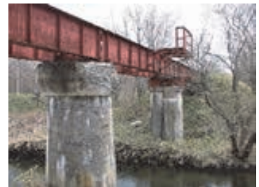
写真 9-12 国鉄標津線当幌川 橋梁
