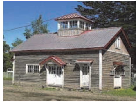
写真 2-8 旧北海道農事試験場 根室支場農具庫
