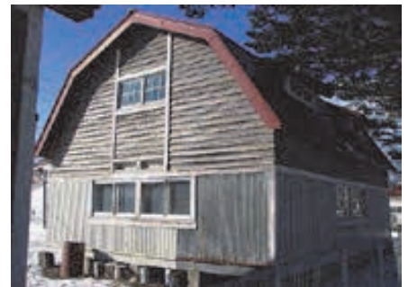
写真 2-9 旧北海道農事試験場 根室支場種苗倉庫
