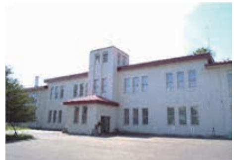
写真 2-6 旧北海道農事試験場根室支場庁舎(現伝成館)
