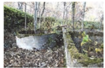
写真 9-6 志賀澱粉工場の遺構
