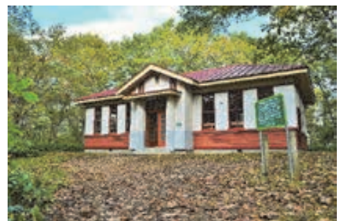
写真 2-7 旧北海道農事試験場根室支場陳列館
