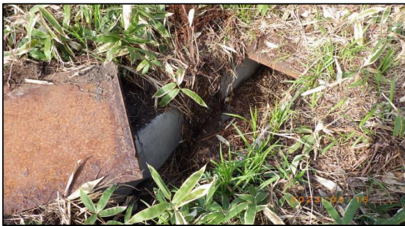
排水トラフ・コンクリート工作物
