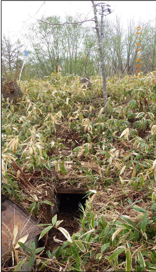
排水トラフ・コンクリート工作物
