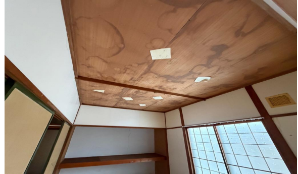
建物内部（和室2天井）
