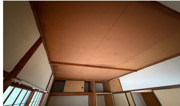
建物内部（和室1天井）
