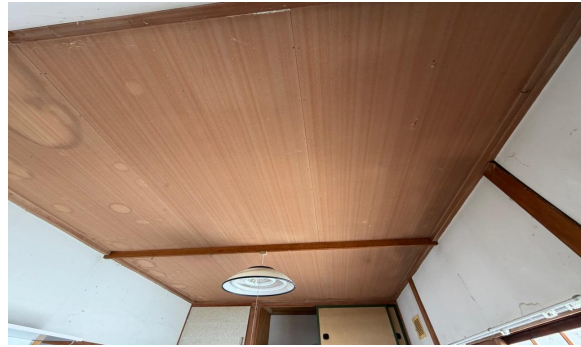
建物内部（洋室1天井）
