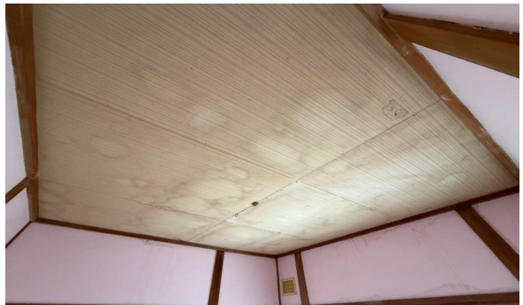
建物内部（和室3天井）
