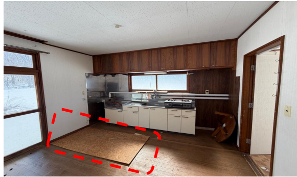
建物内部（キッチン）※床落ち部分有
