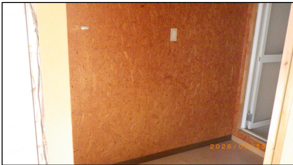
建物内部（脱衣室）
