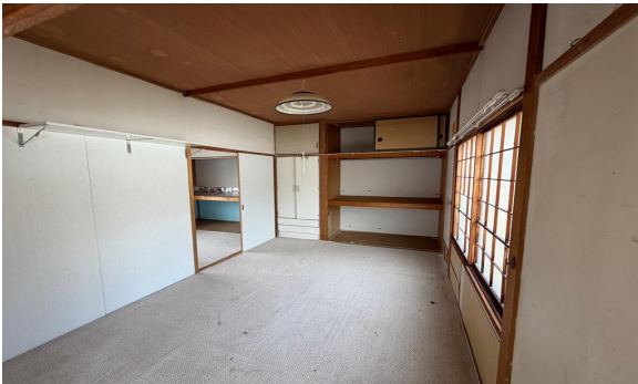
建物内部（洋室1）
