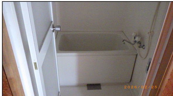
建物内部（浴室）
