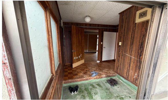
建物内部（玄関）
