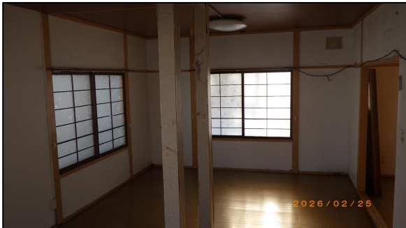
建物内部（洋室）
