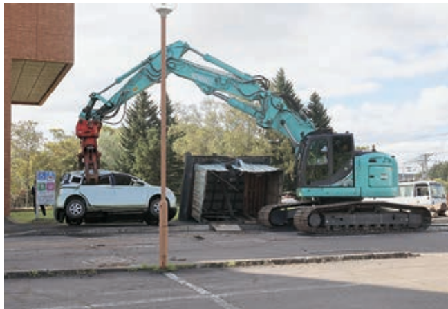
中標津建設業協会による啓開訓練
