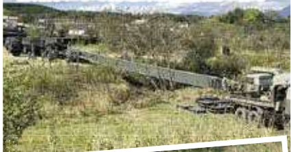
自衛隊による応急架設橋設置の様子
