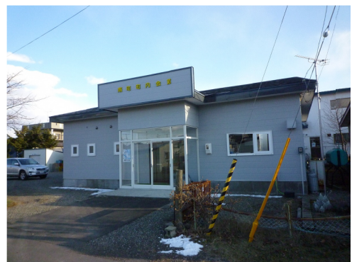
南町町内会活動拠点の町内会館
