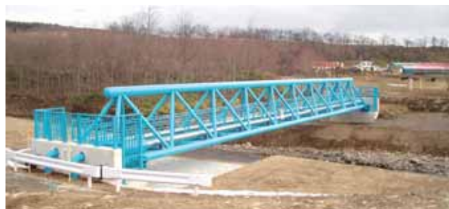
道営畑地帯総合整備事業（開陽地区）で施工された水管橋
