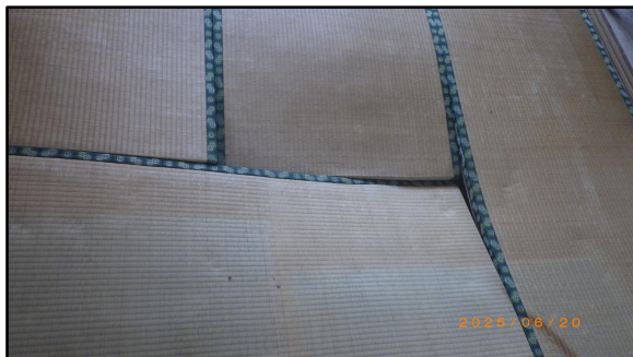
建物内部（1番1の2） ※床落ち
