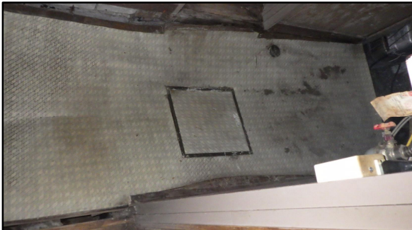
建物内部（1番1の1） ※床落ち
